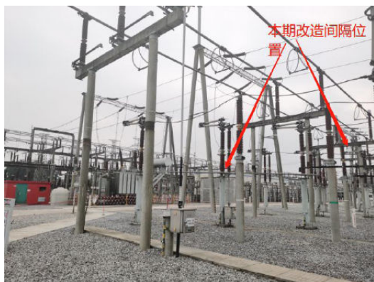
高石 220kV 变电站现状
